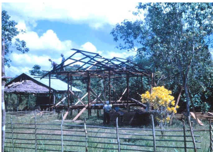
Alte und neue Kirche, letztere im Bau
